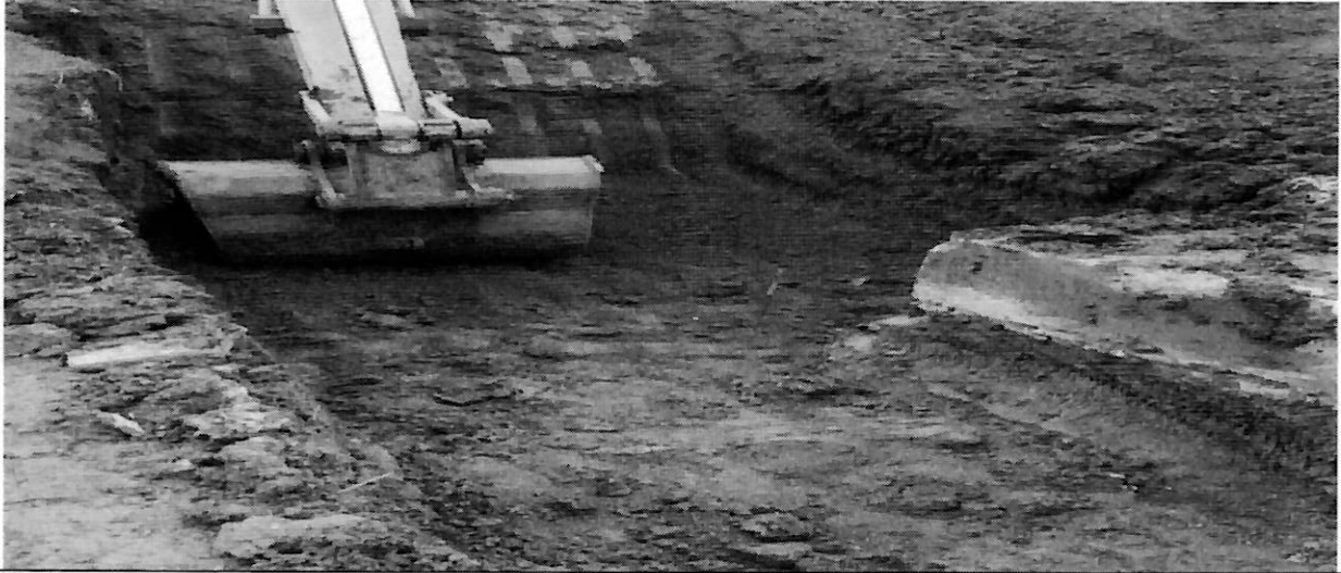
➤ FOTO No.1 EXCAVACION
