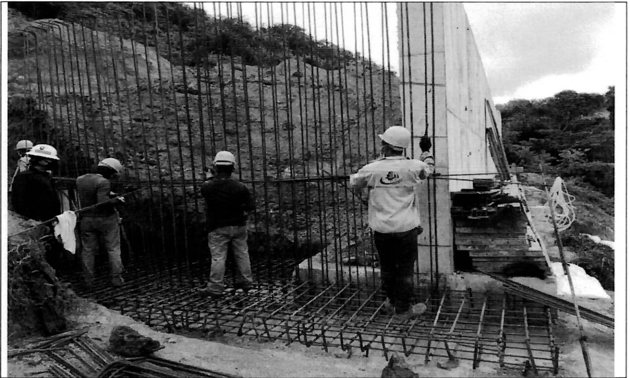
FOTO No.5 ARMADO EN ACERO DE MURO
