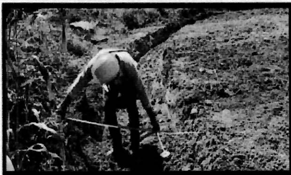
EXCAVACIONES PARA CONFORMACION DE GAVIONES Y ZANJAS PARA CONTROL DE ESCORRENTIAS PLUVIOMETRICA
