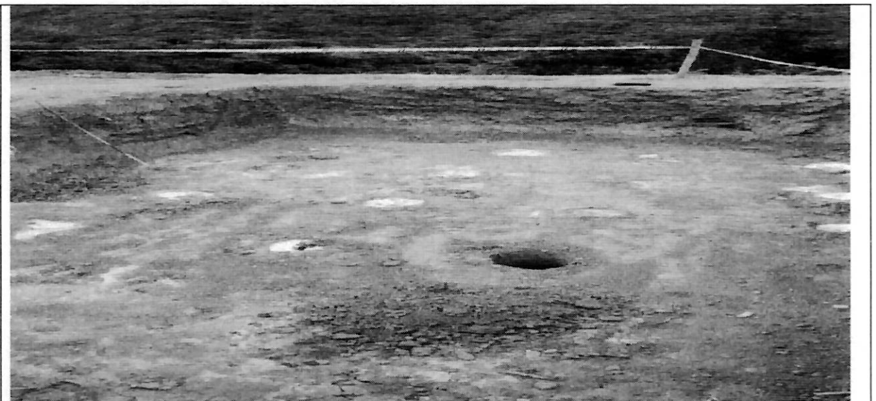
FOTO No.6 EXCAVACIÓN PILOTINES.
