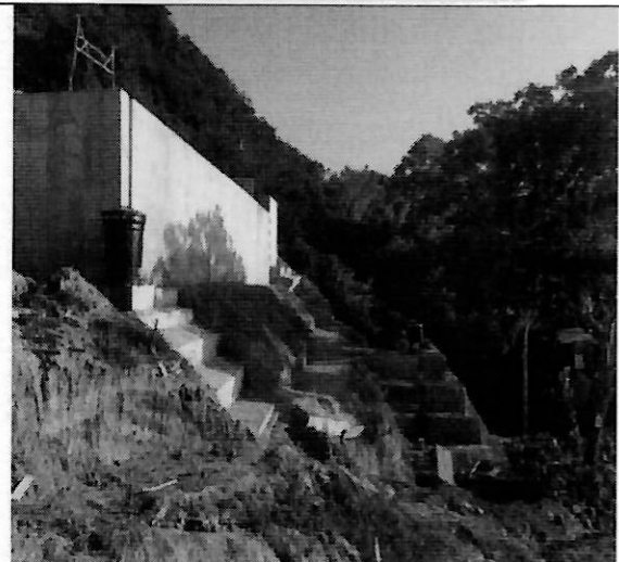
CONCRETO CICLOPEO COMO BASE DE CIMENTACION MURO FRONTAL CON SU RESPECTIVO DISIPADOR
