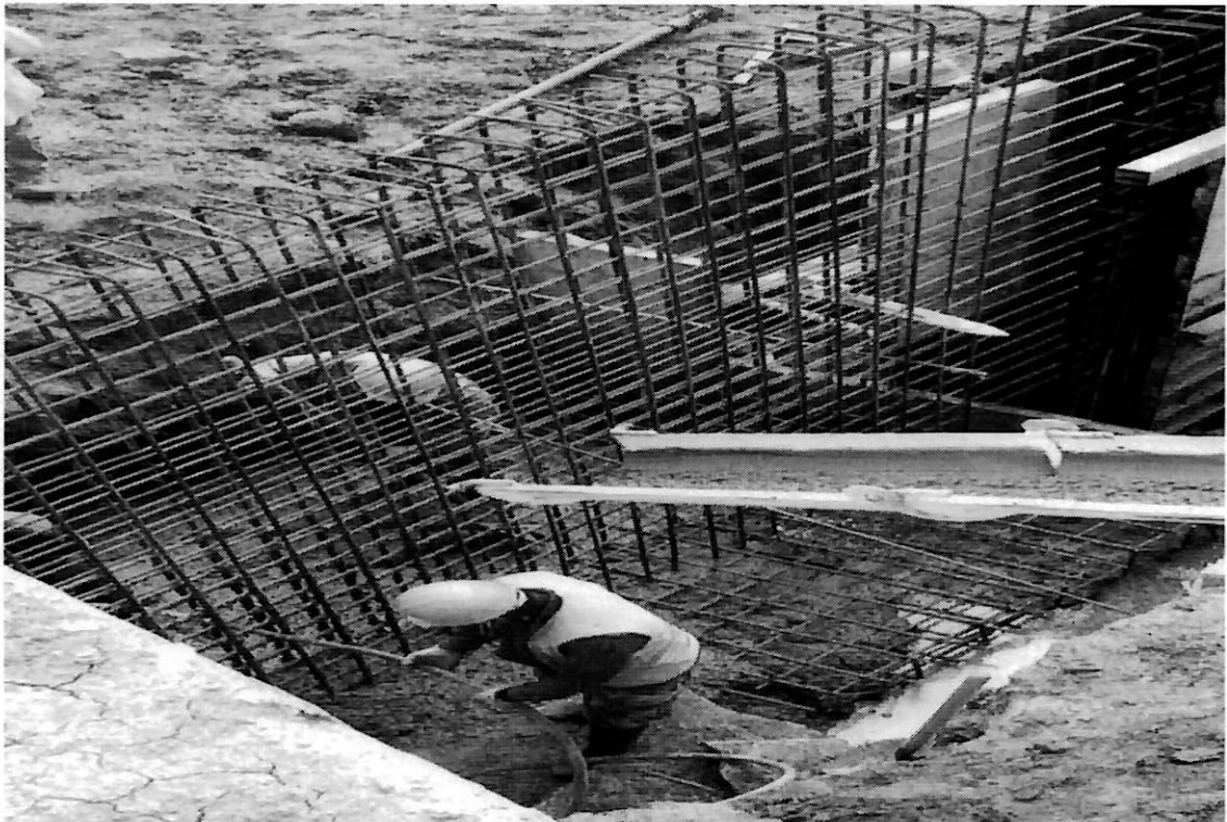
FOTO No.2 FUNDIDA DE ZAPATA
